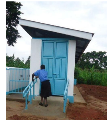
Bloc sanitaire avec toilette étudiée, doté d'une rampe et d'un chemin d'accès plane. Photo : Plan International
